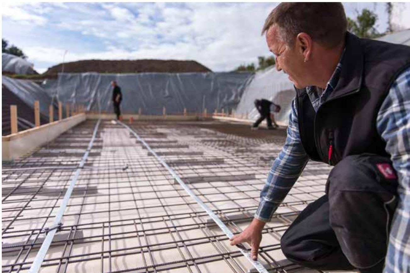
Bild 2.75: Verlegung eines Fundamenterders
