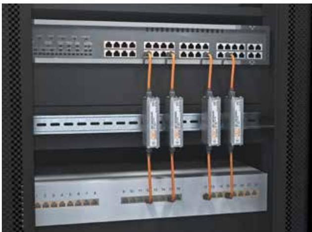
*Bild 3.81 Schutzvorschlag am Switch mit Patchfeld.
