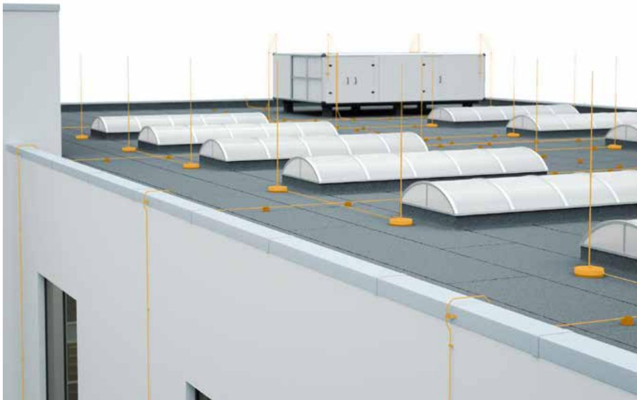
Bild 2.14: Natürliche Bestandteile (hier Attikablech) für Fangeinrichtungen, VDE 0185-305-3 (IEC 62305-3)
