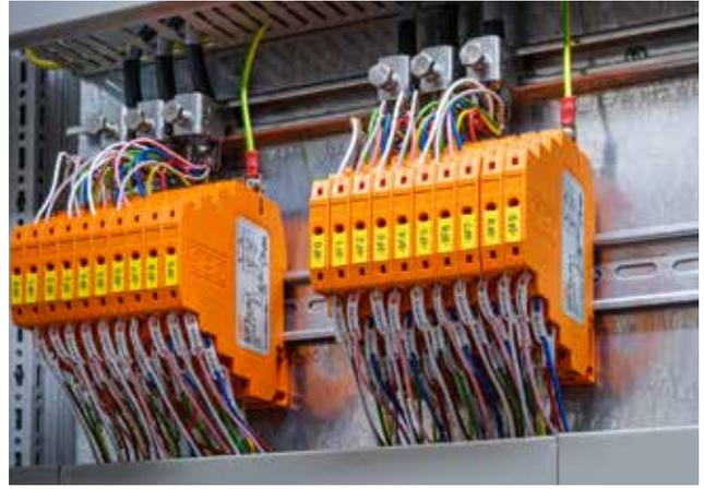
Bild 3.44: Anschluss der Kabelschirme mit der SAS Bügelschelle zum Anschluss des Schirmgeflechtes und MDP Überspannungsschutzgeräten
