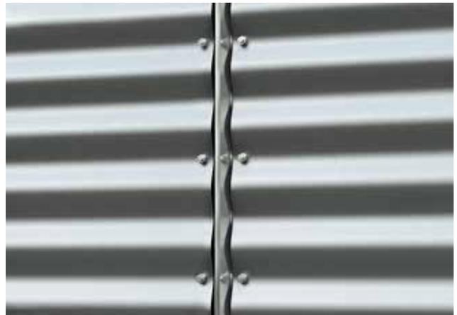
Bild 2.52: Beispiel: Nutzung von horizontal verbundenen Fassadenelementen als Ableitungseinrichtung
