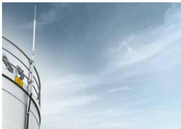
Bild 2.58: Getrennter Blitzschutz mit isCon®
