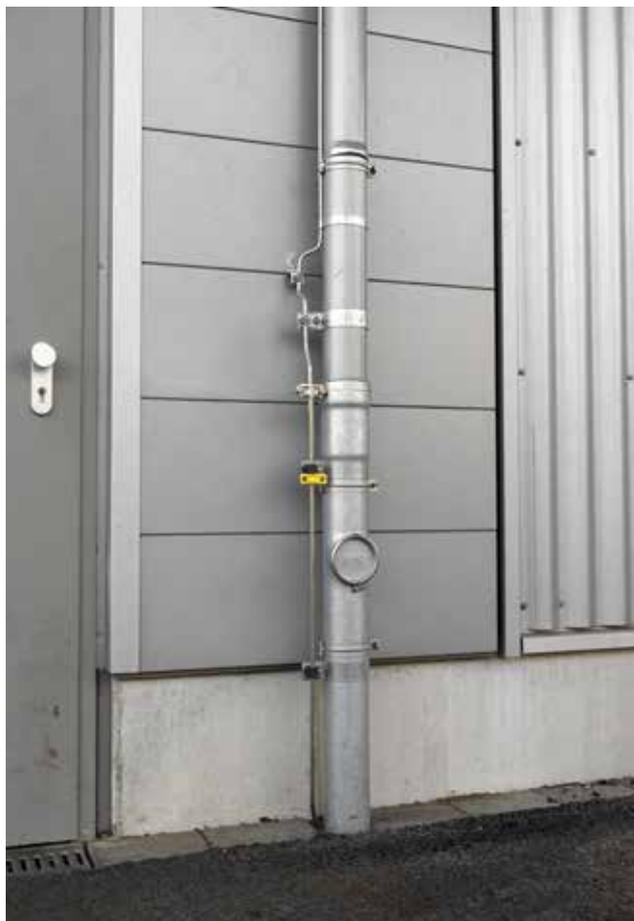
Bild 2.18: Blitzschutz-Ableitung an einem Regenfallrohr
