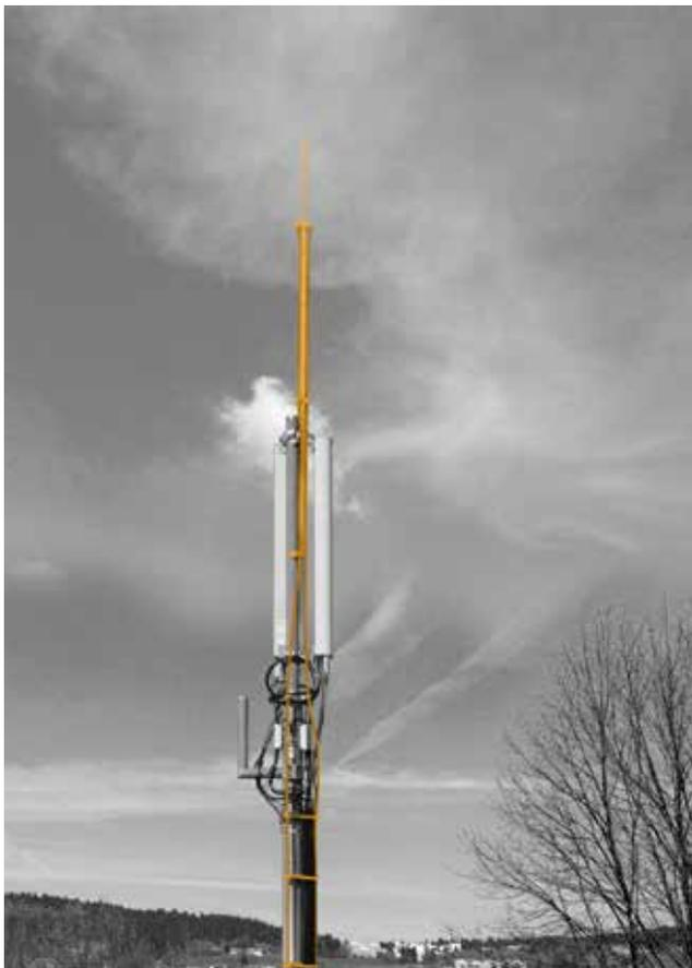
Bild 2.72: Mobilfunkmast mit isCon®-Leitung
