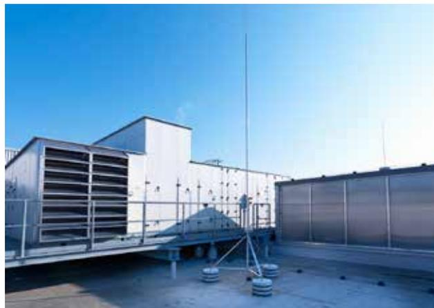
Bild 2.29: Fangmast aus Aluminium
