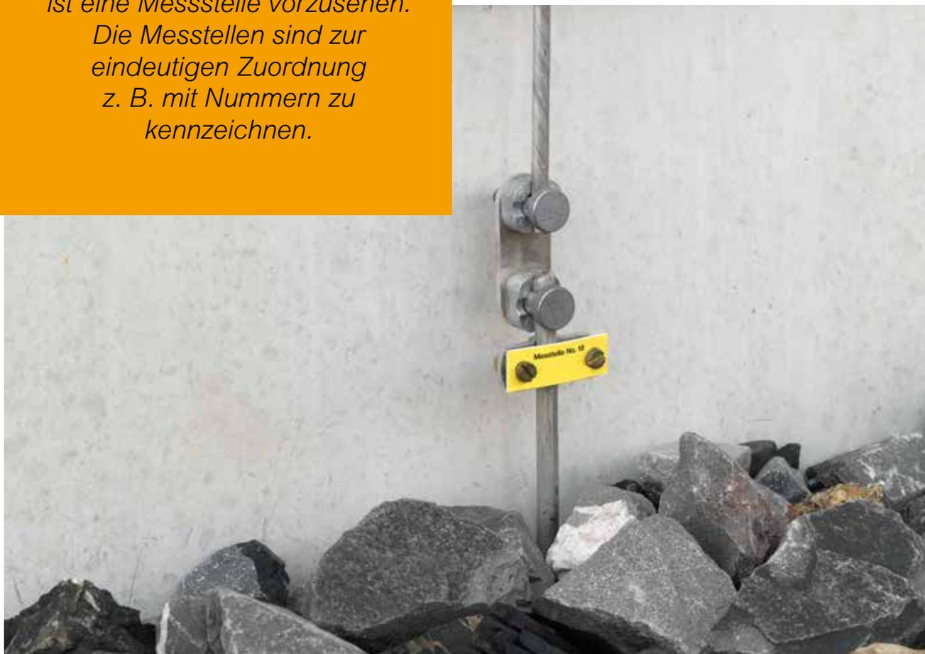
Bild 2.48: Messstelle an der Erdführung
