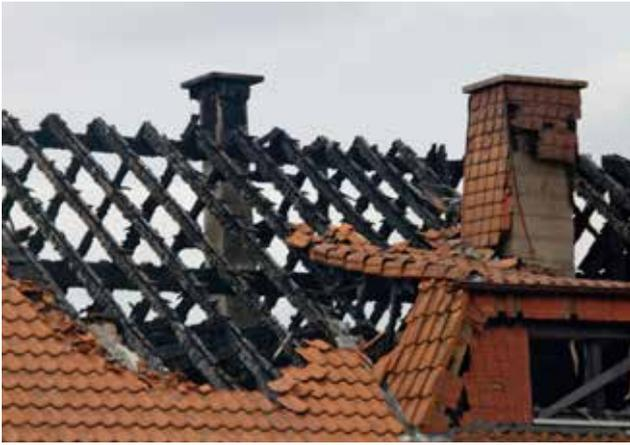
Bild 1.19: Gebäudeschäden durch direkten Blitzeinschlag
