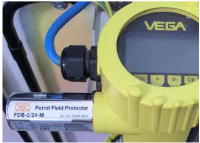
Bild 3.66: Sensor mit Petrol Field Protector (siehe Punkt 7 in Bild 3.68)
