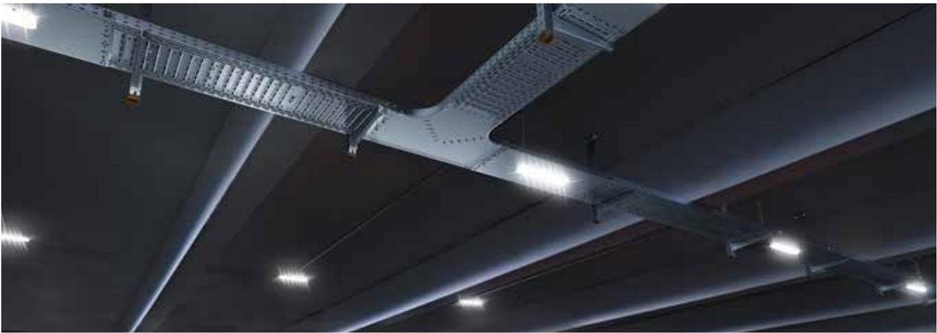
Bild 3.29: LED-Beleuchtungssystem in einem Parkhaus
