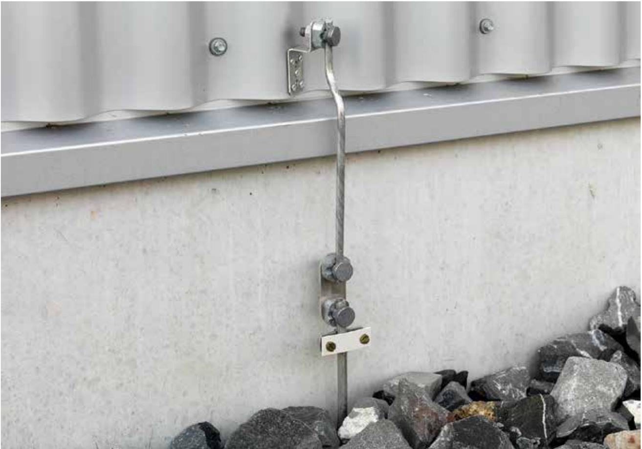
Bild 4.1: Trennstelle an einer Metallfassade
