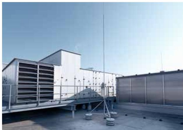
Bild 2.22: Isolierter Blitzschutz mit isFang
