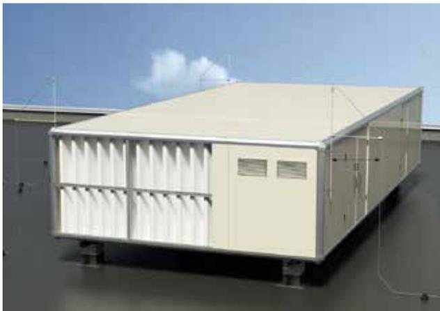
Bild 2.28: Isolierte Fangeinrichtung mit Trennungsabstand (s)
